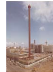
レインボータワー工事
